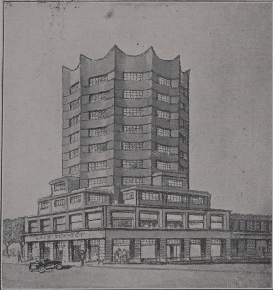
Fig. VIII. — Garage allemand à deux ascenseurs (Wickop, architecte). — Cette tour octogonale comporte 9 étages (le nombre de boxes est de 9 à 10, selon les étages). Deux ascenseurs assurent la montée et la descente.
