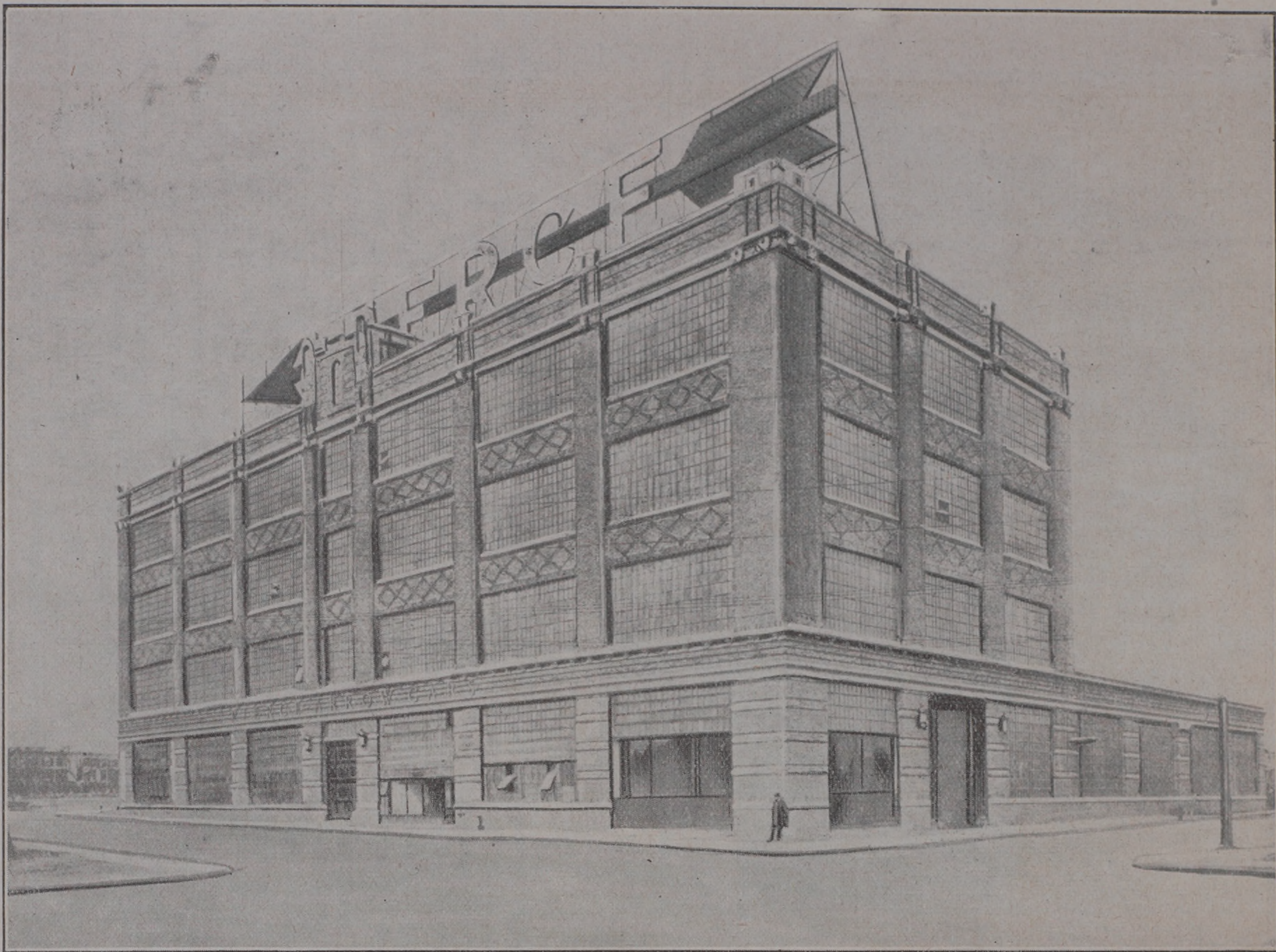
Fig. X. — Façade principale du Garage Pierce Arrow à Long Island (Griffin et Wynkoop, architectes). — Ce garage est un bel exemple de publicité monumentale à l'usage des garagistes.
